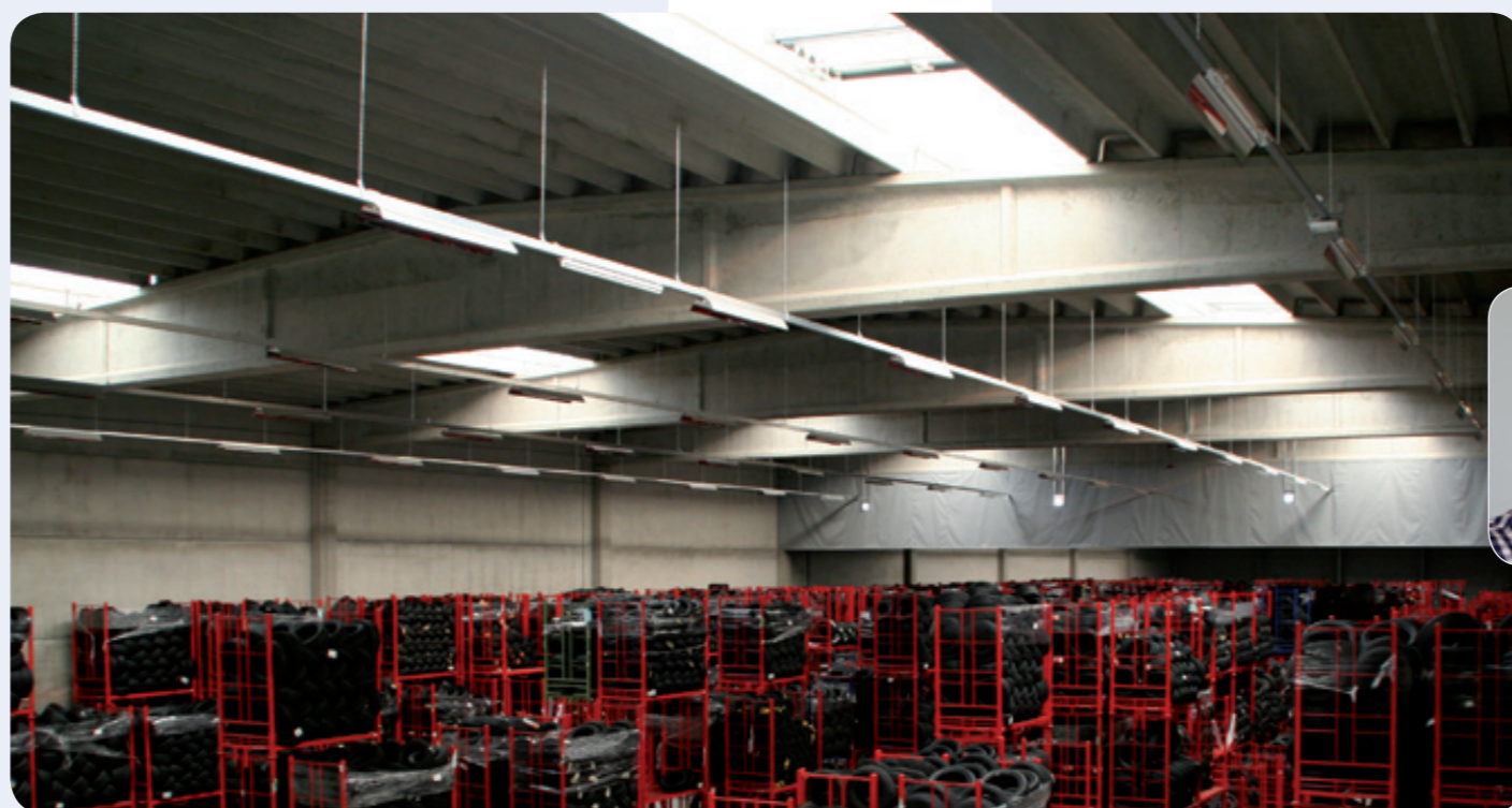
Rook- en warmteafvoer, rookschermen en detectie zorgen voor een brandveilige situatie
