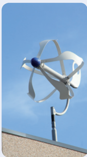
Pilot duurzaamheid: 10 windbollen die per stuk 2000-2500 kW moeten opbrengen, nagenoeg het complete verbruik van het project.
